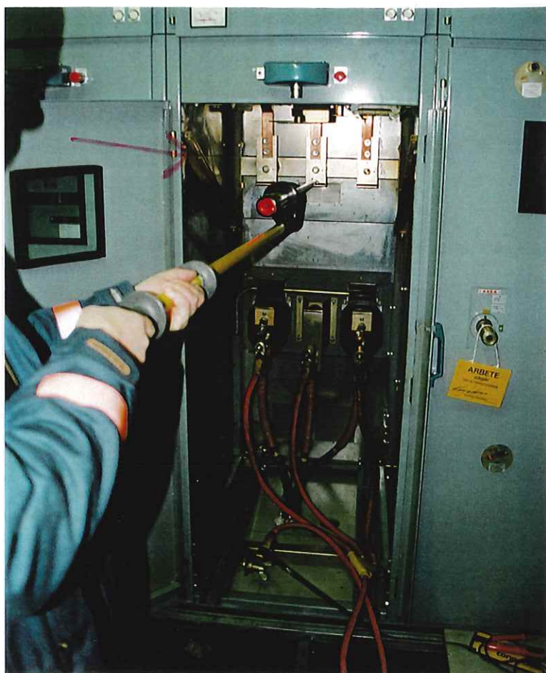
Foto 3 visar hur det går till att kontrollera spänningen. Här används rätt spänningsprovare som klarar 10 000 v. Pil visar en av skenorna där plexiglasskivan skall sitta.
