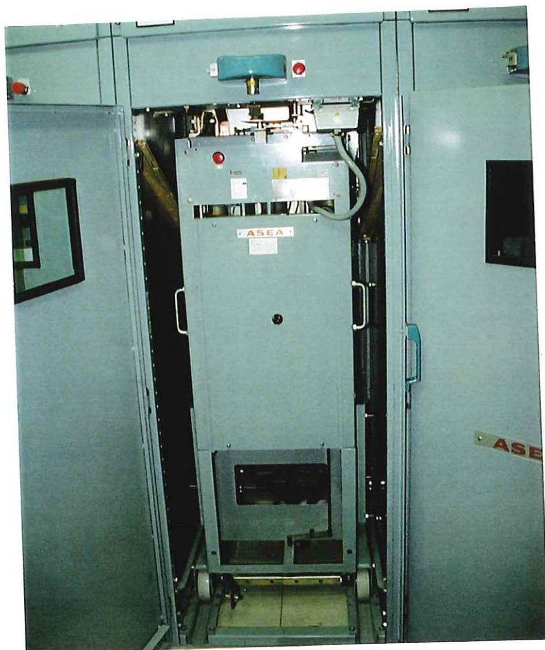
Foto 1 visar det aktuella facket. Här är brytarvagnen på plats.
