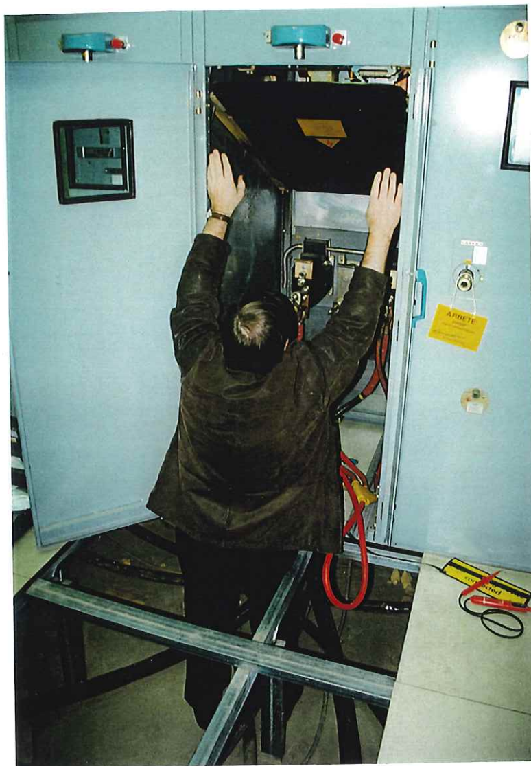
Foto 5 visar att det går att komma åt de övre spänningsförande hornen även om man står på golvet.
