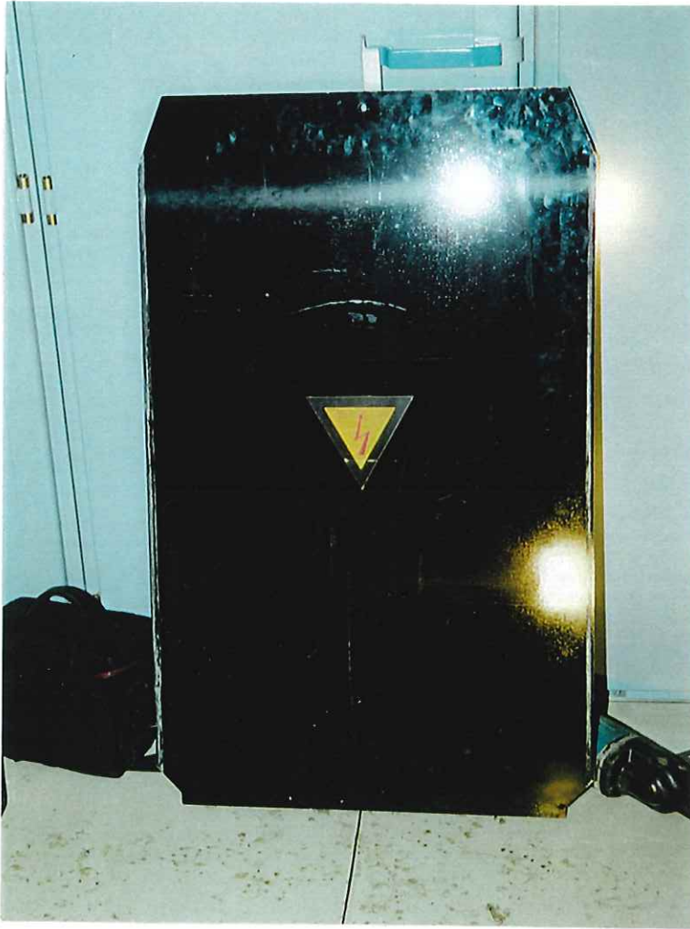
Fotot visar den skiva som skulle varit insatt i skenorna i facket. Skivan står vid undersökningstillfället i ett angränsande rum.
